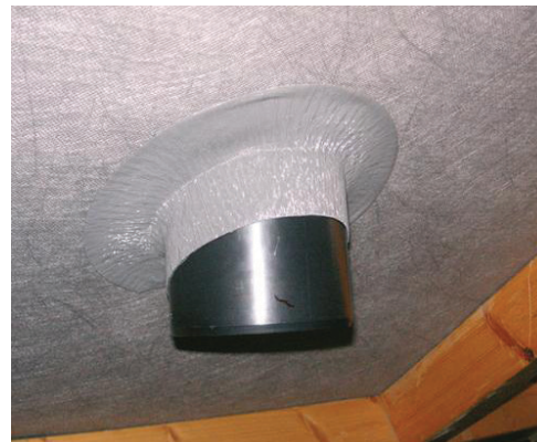
Pilt 19. Tuulutuskorstna tihendamine Easy Form tihendusteibiga
