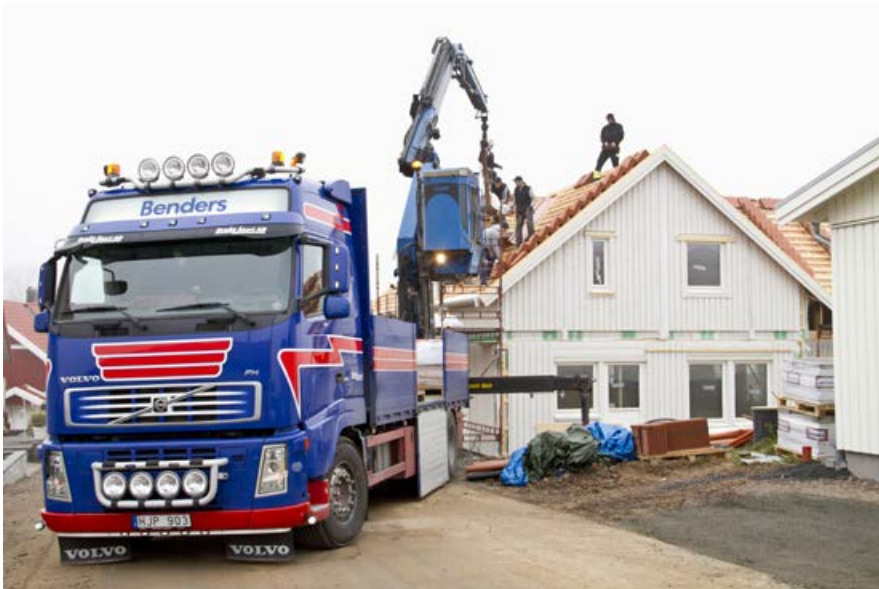
Pilt 1. Kraanaga autolt katusele tõste.
