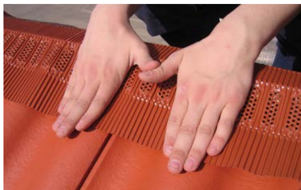
Samm 3. Veenduge, et paigaldusel õhutusosa ei läheks vastu harjaroovi vaid jääks sirgjooneliselt laskuv, et tuulutus toimiks vastavalt nõuetele.
