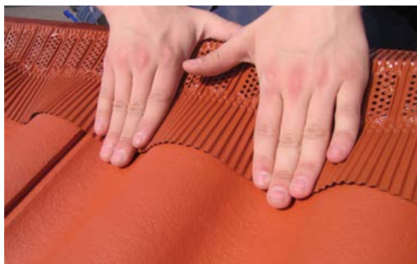
Samm 4. Paigaldades harjatihendit kivi lainesse, veenduge et tihend saaks paigaldatud vastu kivipinda. Oluline on, et suruksite kõik ääred korralikult vastu kivi, nii saab sõlm korralikult tihendatud.
