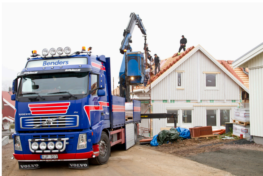
Pilt 1. Kraanaga autolt katusele tõste.
