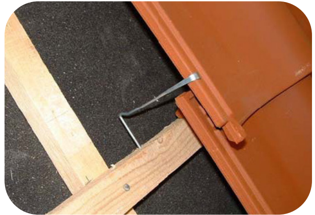
Lapetiilikiinnike kiinnitetään vesilukosta ruoteeseen.
