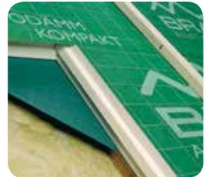
Beispiel: geschlossene Deckunterlage mit DivoDämm.
