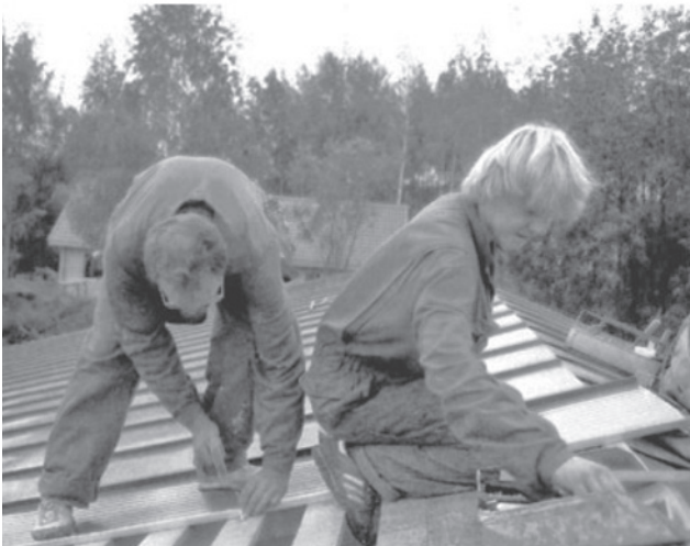
Plekitahvlite kinnitamine ribadega.
