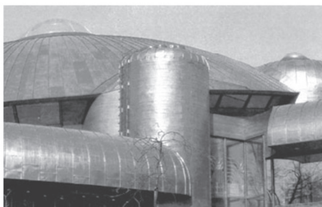
Vaskplekist katuse- ja seinakatte võib ka jäigalt kinnitada, kui õmblused järgivad katuse ja hoone kuju. Tampere Metso-raamatukogu.
