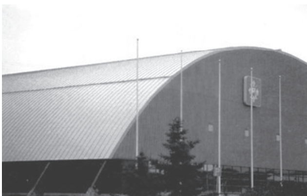
Pikkadel viiludel tehakse liikuvad valtsühendused.
