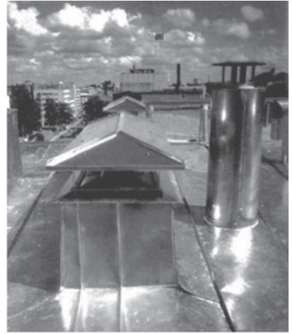
Korstnate lausplekitus. Toru läbiviik on viiluplekiga kokku valtsitud, valtsõmblused tihendatud.
