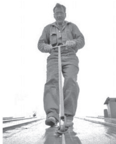
Püstõmbluse mehaniseeritud valtsimine.
