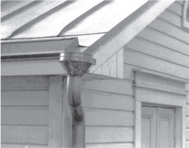
Veetõkke ja otsaräästa ühinemiskohal olev veesüliti koos veetoruga.
