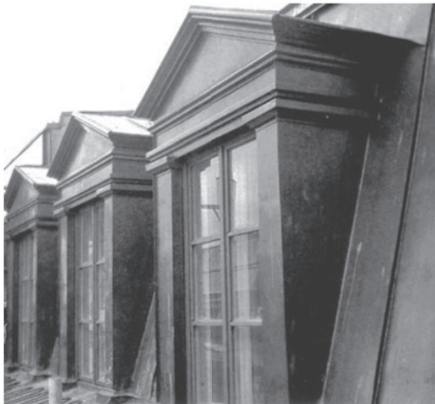
Katuseplekituse liitumine akendega, millel on mitmesuguseid detaile.
